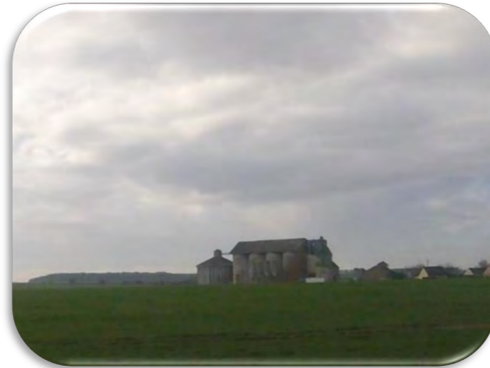
Site industriel - Silo
